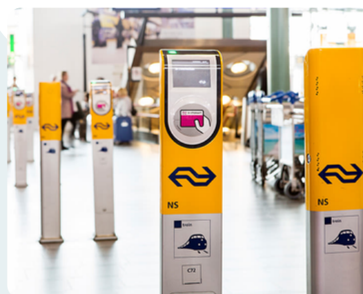
▲ 無閘門車站的刷卡處
